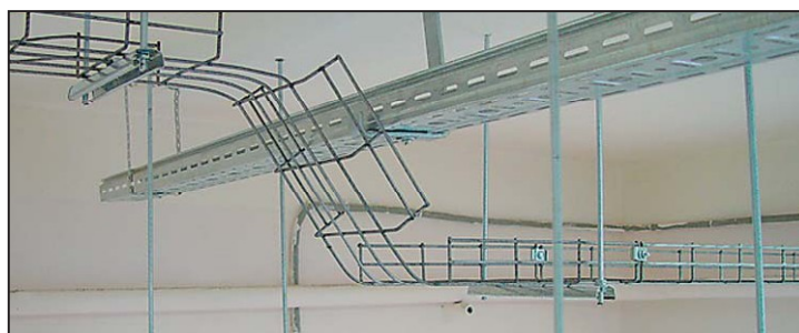
Пример монтажа кабельной трассы
